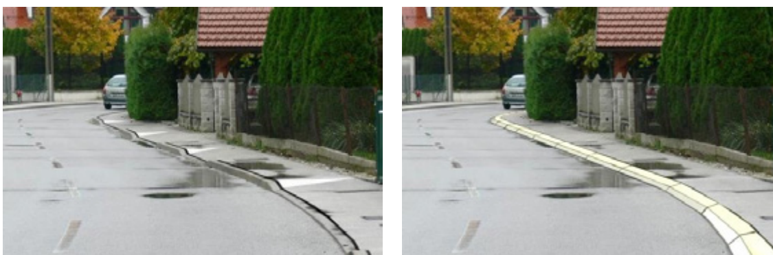
Slika 25: Trenuten pešcem neprijazen (valovit) pločnik (levo) in predlog nižanih pločnikov s posnetim robnikom (desno)
